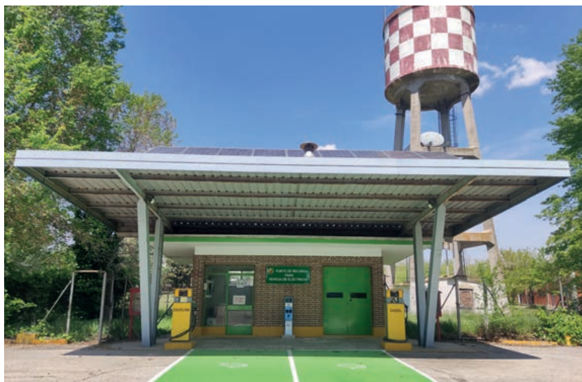
Punto de recarga de vehículos eléctricos en el CLOMA
